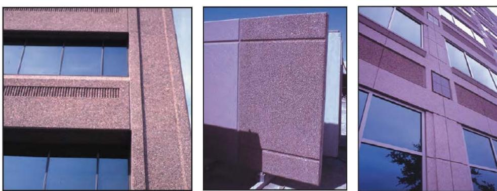
شکل ۱۰-۲-الف- پانل پتنی پیش ساخته با جزئیات سطح صیقلی ب- پانل‌های پتنی پیش ساخته با سطح سمباده‌ای کم و متوسط ج- پانل پتنی با رویه سنگدانه نمایان
