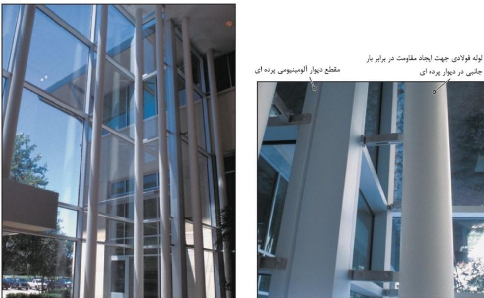
شکل ۹-۲۱-۹- نمای پرده‌ای بلند، جهت تامین مقاومت جانبی به قاب فولادی سازه متصل شده است
