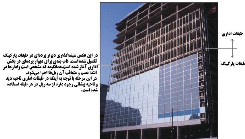
شکل ۶-۹- مراحل نصب دیوارپرده‌ای شیشه‌ای درجا در یک ساختمان اداری که در آن طبقات زیرین بارگیری و طبقات بالایی اداری است
