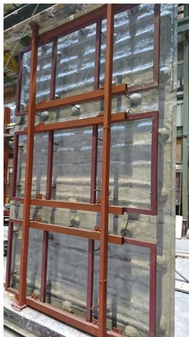
شکل ۱۲-۱۱-ب- نمای پشت یک پانل GFRC همراه با قاب فولادی
