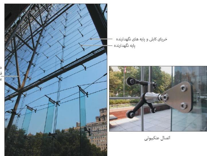
شکل ۱۸-۹-جزئیات نمای پرده‌ای شیشه‌ای با شیشه نصب شده از داخل
