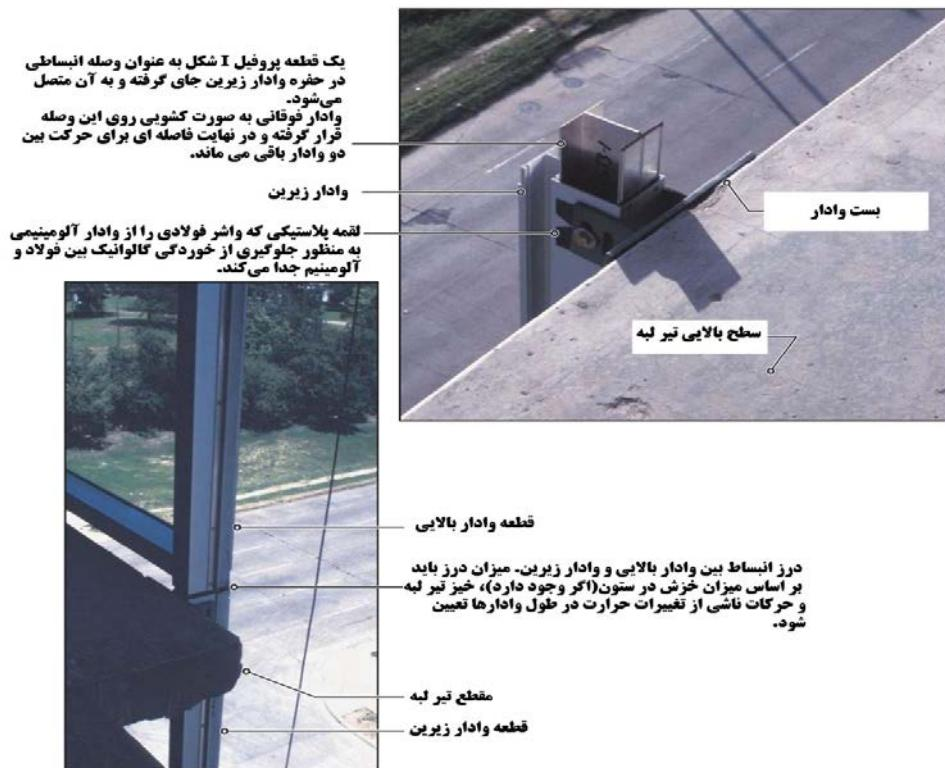
شکل ۷-۹- نمونه اتصال انبساطی بین دو قطعه وادر
