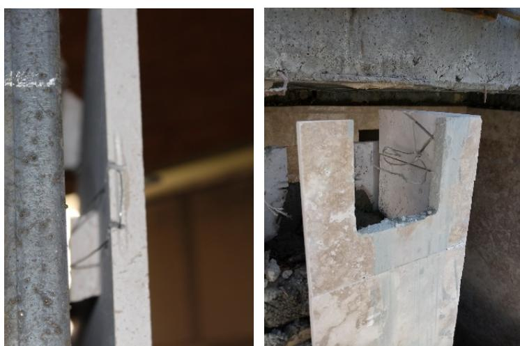
شکل ۲-۴- نمونه‌هایی از مهارهای سیمی فولادی
