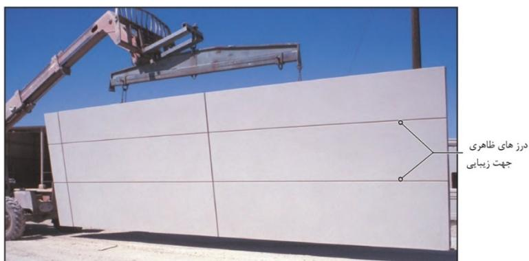
شکل ۱۲-۱۱-الف- سطح بیرونی یک پانل GFRC، در حال حمل در کارگاه
