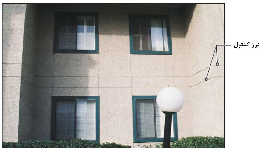
شکل ۶-۲- نمونه درزهای کنترل بر روی نمای سیمانی
