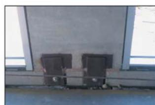
شکل ۸-۱۰- تیپ اتصالات دوخت به پشت که در سه جهت قابل تنظیم می‌باشد
