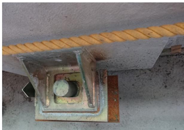
شکل ۱۰-۶- نمونه هایی از عنایین تکیه گاه انتکایی در پانل های بتونی پیش ساخته
